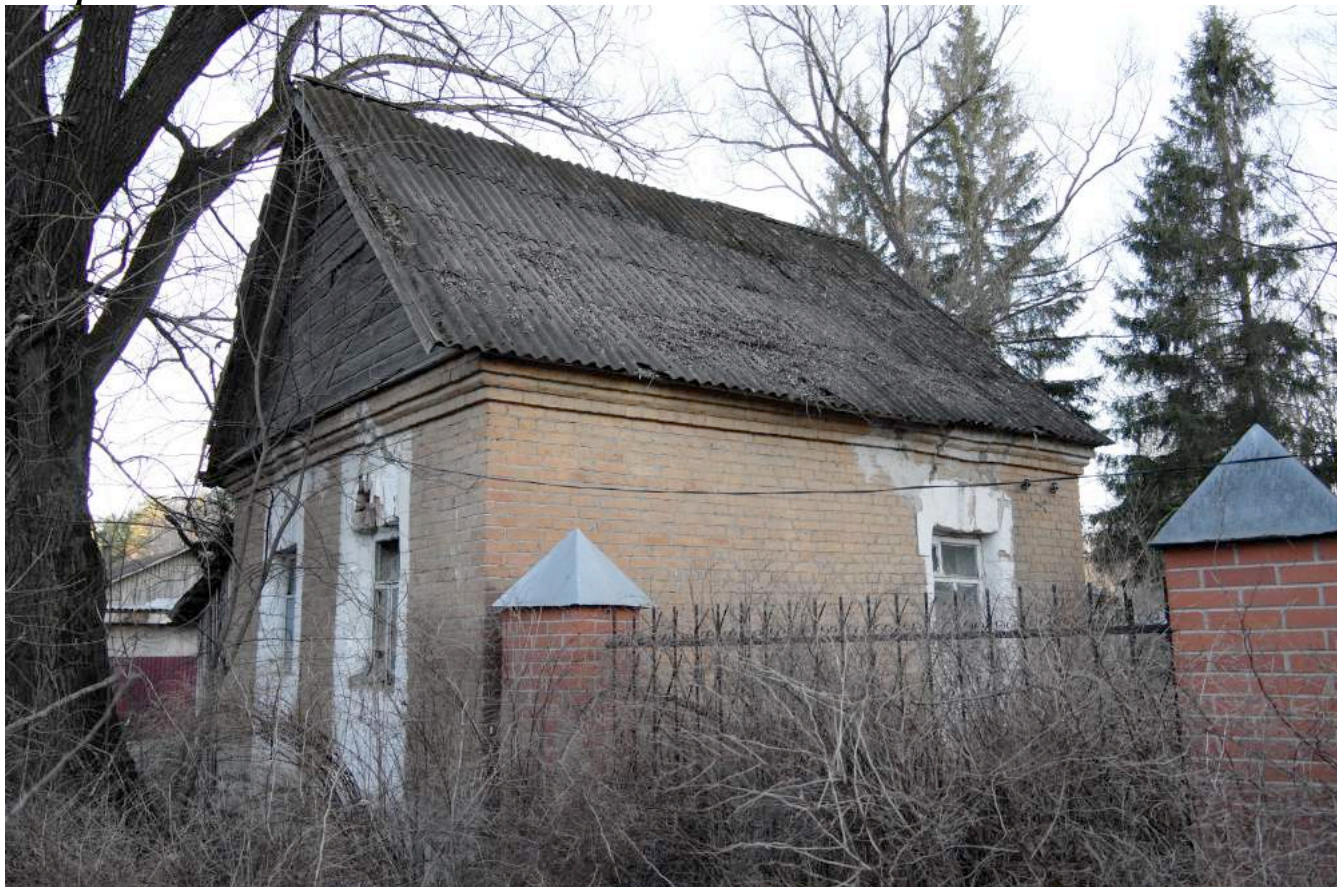
Фото 1. Вид с северо-запада.
